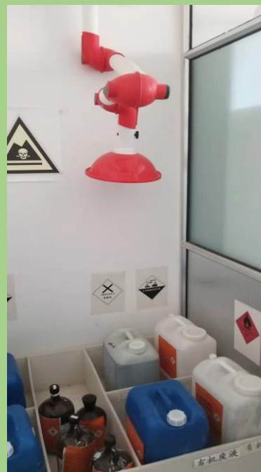
危废废物废气收集
