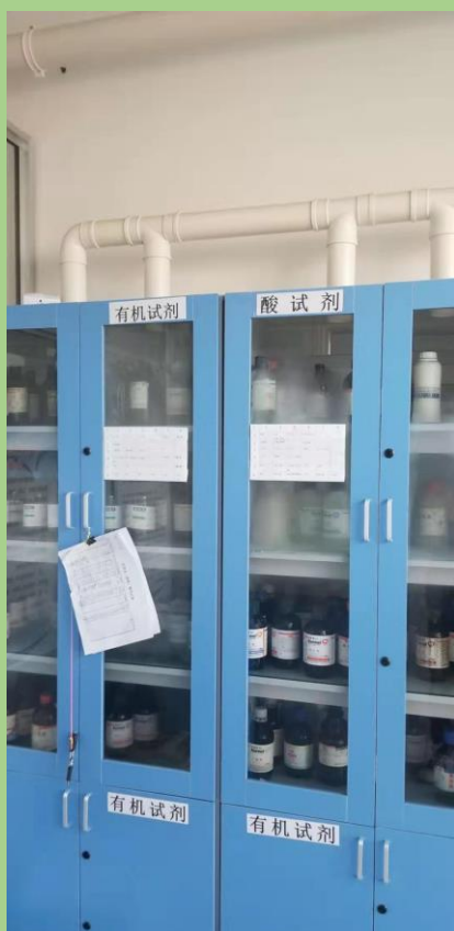
试剂柜分区、废气收集
